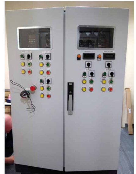
Fot. 2. Widok drzwi szafy
